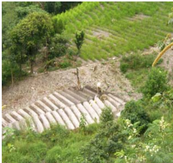
Construcción de terrazas, Yungas de La Paz
